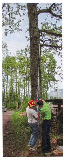
On peut mettre en place un câble rapidement et en toute sécurité à l'aide d'une perche télescopique.
