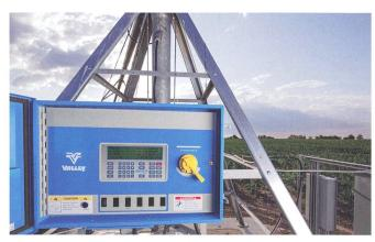
La tour centrale d'un pivot ou d'une rampe frontale est le «cerveau» de l'installation. C'est ici qu'arrive l'eau avant d'être distribuée vers l'installation. Photo: Valley
