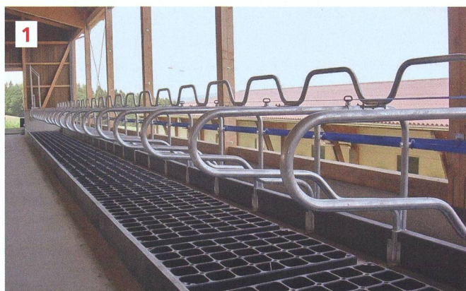
Les éléments à alvéoles en caoutchouc doivent être parfaitement alignés et vissés sur la dalle en béton avec douze boulons.
