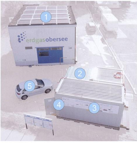
L'installation de démonstration de Rapperswil présente toutes les étapes: centrale solaire (1), production de CO₂ (2), électrolyse (3), méthanisation (4) et ravitaillement du véhicule au gaz naturel (5).
