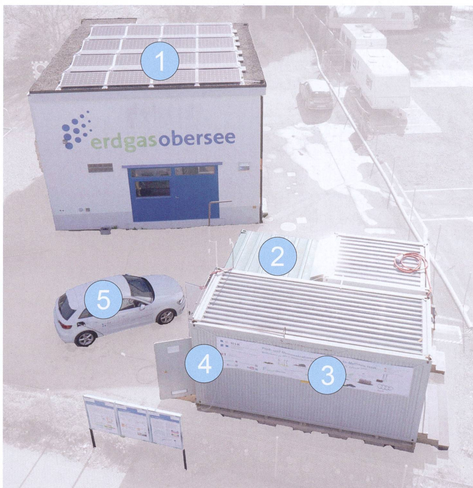
L'installation de démonstration de Rapperswil présente toutes les étapes : centrale solaire (1), production de CO 2 (2), électrolyse (3), méthanisation (4) et ravitaillement du véhicule au gaz naturel (5).
