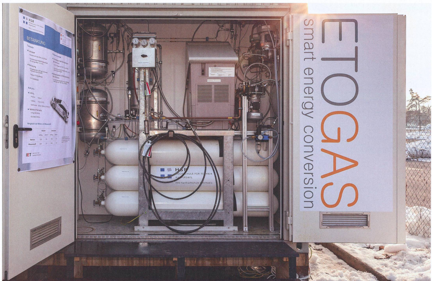
Station-service : le méthane produit est comprimé à l'aide de compresseurs et stocké dans des bombonnes.
