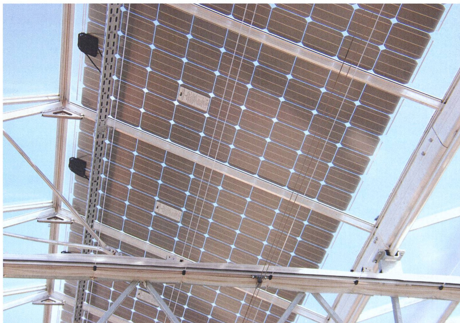
Les modules solaires verre/verre forment le toit, ce qui demande une construction renforcée.
