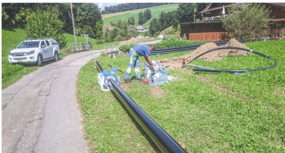
Le soudage des tuyaux de pression en PE requiert une formation spécialisée et il est conseillé de confier cette tâche à un spécialiste.
