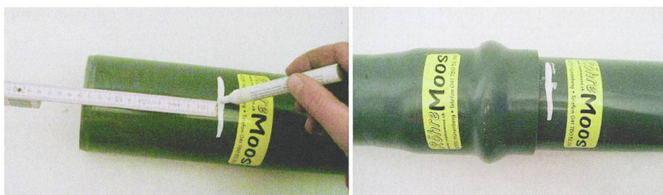
En revanche, les tuyaux en PVC-U avec manchon à emboîter sont conçus également pour être posés par l'agriculteur. Il est très important de marquer la partie à emboîter pour s'assurer que chaque manchon est emboîté jusqu'à la butée.
