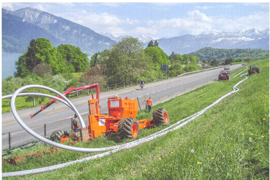
L'excavation permet également de poser plusieurs conduites dans le sol en une seule opération. Un guidage laser détermine la pente avec précision.
