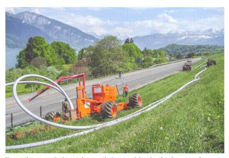
L'excavation permet également de poser plusieurs conduites dans le sol en une seule opération. Un guidage laser détermine la pente avec précision.
