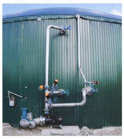
de substrat par rapport aux stations traditionnelles à brassage mécanique. La durée des différentes phases varie d'une installation à l'autre. En règle générale, un cycle de fonctionnement de 10 à 20 minutes par heure est préconisé.
