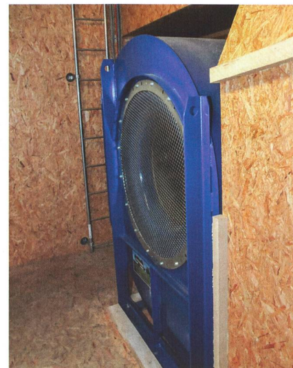
Le ventilateur spécial à pression constante demande une puissance électrique maximale de 22 kW.
