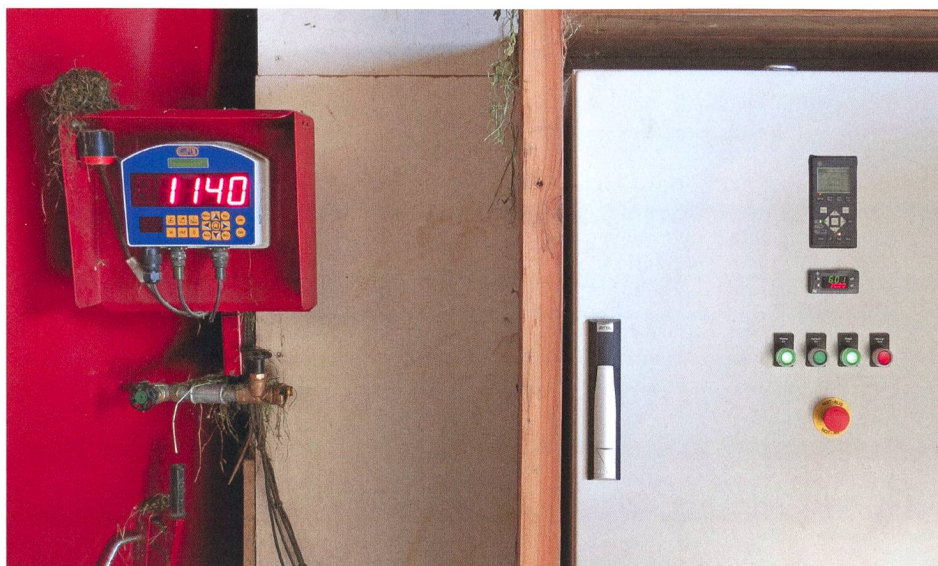
A gauche: installation de pesage HL 50. A droite: armoire de commande avec changeur de fréquence, minuterie et touches de commande.
