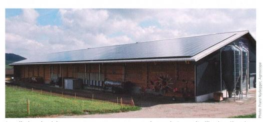
Installation de séchage en grange avec panneaux photovoltaïques: l'utilisation électrique et thermique de l'énergie solaire permet un séchage du foin sans impact sur le climat.
