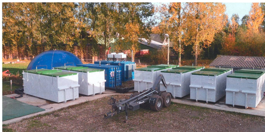
Dans l'installation «Eribox», les containers font office de digesteurs, cette solution offre beaucoup de flexibilité dans sa mise en œuvre. (Source : ©Erigène, www.erigene.com )
