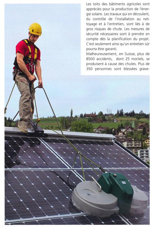
Avec le système Firstkönig, une protection permanente contre les chutes est garantie dés que lorsque l'on monte sur le toit. (Photo: Firstkönig)
