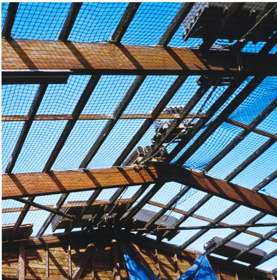
Protection individuelle: un filet évite des chutes lors des travaux sur le toit. (Photo du SPAA)
