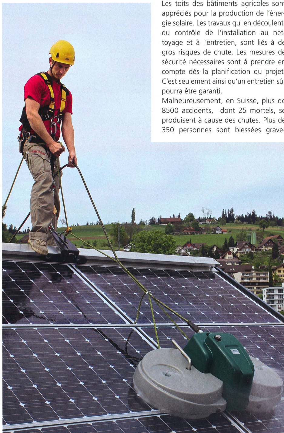
Avec le système Firstkönig, une protection permanente contre les chutes est garantie dès que lorsque l'on monte sur le toit. (Photo : Firstkönig)
