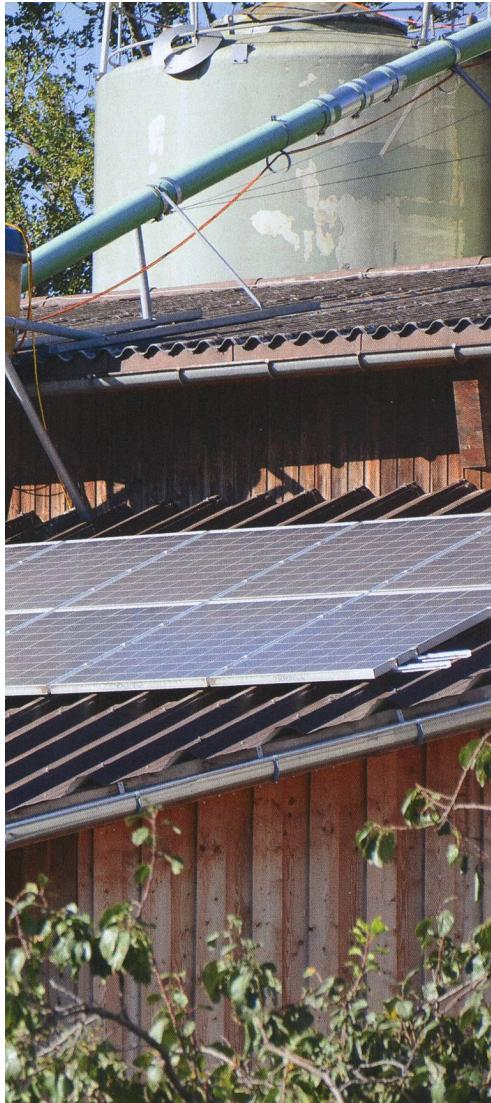
Une installation solaire comprenant des modules d'orientation et d'inclinaison diverses sollicite beaucoup l'appareil de branchement au réseau et son onduleur.
