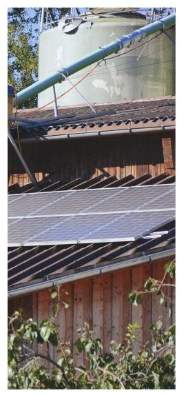
Une installation solaire comprenant des modules d'orientation et d'inclinaison diverses sollicite beaucoup l'appareil de branchement au réseau et son onduleur. (Photo: Ruedi Hunger)
