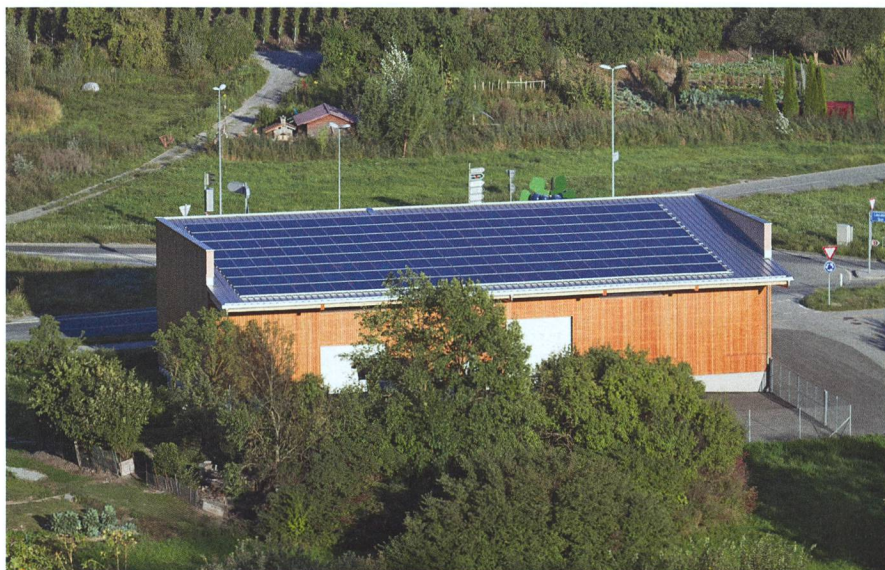
La mise en service, en septembre 2012, des panneaux solaires sur le bâtiment d'agronomie de la Cave du Rhodan à Salquenen fait partie du projet EEE et produit environ 50 000 kWh d'électricité par an.
