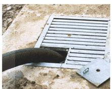
Une petite ouverture de prélèvement doit être prévue si l'installation d'un tuyau de prélèvement fixe est impossible. Le couvercle doit être sécurisé contre la chute dans la fosse.
