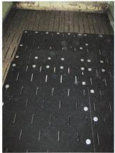
Tapis en caoutchouc avec un pourcentage de perforation de 5 % (Fabricant: Kraiburg Elastik GmbH en Allemagne)
