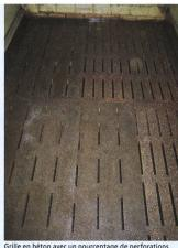
Grille en béton avec un pourcentage de perforation de 6 % (Fabricant: Schmidiger Betonelemente AG)
