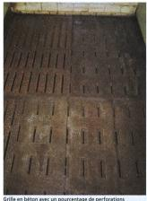
Grille en béton avec un pourcentage de perforations de 5 % (Fabricant: Schmidiger Betonelemente AG)
