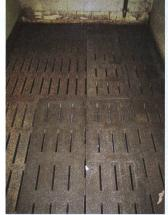
Grille en béton avec un pourcentage de perforations de 8 % (Fabricant: Schmidiger Betonelemente AG)
