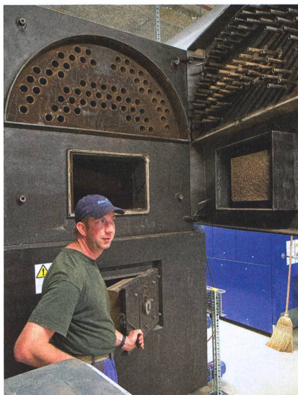
En été, comme ici, la chaudière à plaquettes est à l'arrêt. Elle entre en service quand les besoins en calories dépassent les capacités du cogénérateur.
