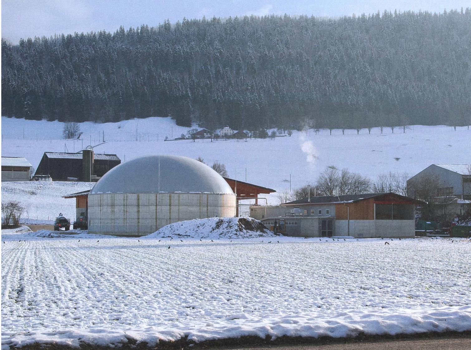
Agri Bio Val vu depuis le nord. Le digesteur (à g.) et le bâtiment qui abrite le cogénérateur, la chaudière et le stock de plaquettes de bois. (Photos : Alain Douard)
