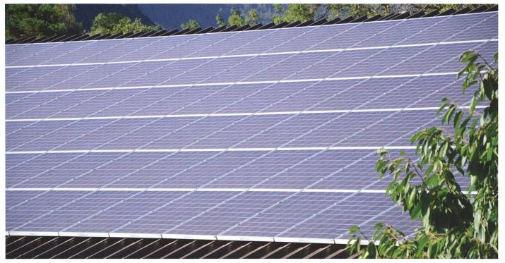
Un seul onduleur suffit quand tous les modules bénéficient d'un rayonnement solaire équivalent. Mais lorsque les parties du toit n'ont pas toutes la même inclinaison, il est recommandé d'équiper séparément chaque groupe de modules d'un onduleur.
