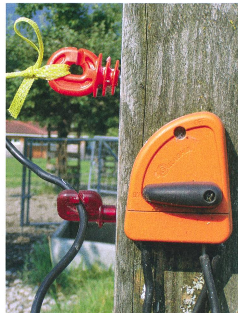
Interrupteur pour enclencher/déclencher différents circuits.
