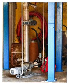
Grâce à l'installation d'une pompe, les effluents peuvent être pompés facilement dans le digesteur.
