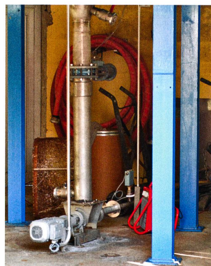
Grâce à l'installation d'une pompe, les effluents peuvent être pompés facilement dans le digesteur.
