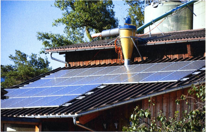
Grâce à une bonne aération, les modules solaires ne chauffent pas trop, et un taux de rendement convenable est assuré.
