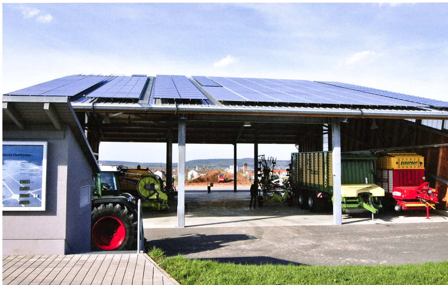
Installation photovoltaïque de démonstration du «landwirtschaftlichen Lehranstalten für Oberfranken» de Bayreuth. Les différents types de modules se distinguent les uns des autres, et, à gauche de la photo, l'indicateur digital permet de lire les performances momentanées et cumulées.
