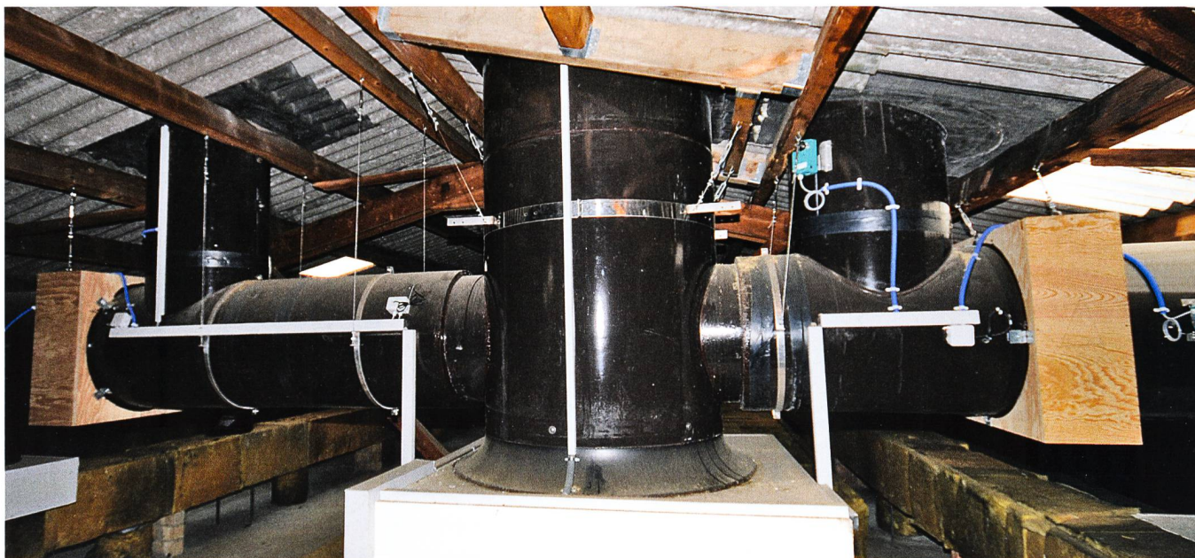
L'installation de récupération de chaleur sous le toit des porcheries et des poulaillers épargne beaucoup d'énergie et permet une meilleure gestion de la ventilation. (Photo: ART)
