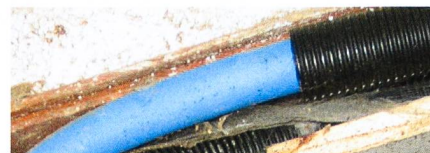
Les tuyaux « Sanipex » disposent d'une couche d'air isolante entre le tube conduisant l'eau et le tuyau qui l'entoure.
