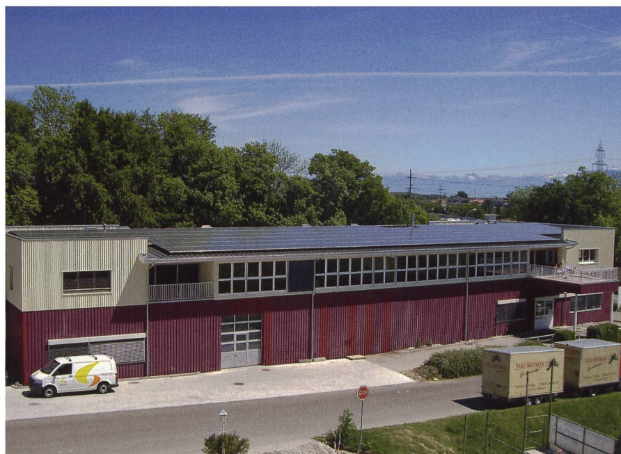
Liniger : la faible pente du toit de ce hangar permet le montage de panneaux solaires sur les deux pans du toit
