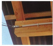
Les fils d'alimentations longeant les bâtiments seront composés de fils à haute tension, tirés dans des tubes difficilement inflammables.
