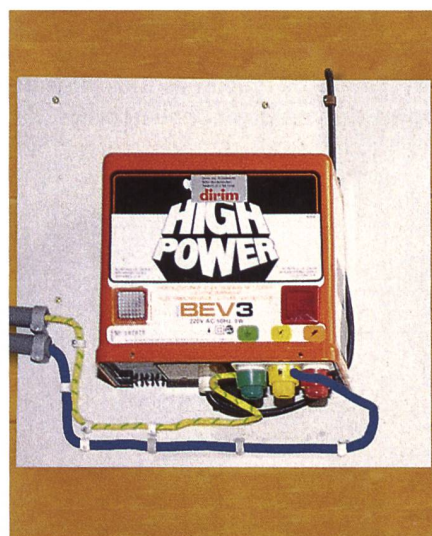
Montage des électrificateurs: sur des supports ignifugés et correctement mis à terre.
