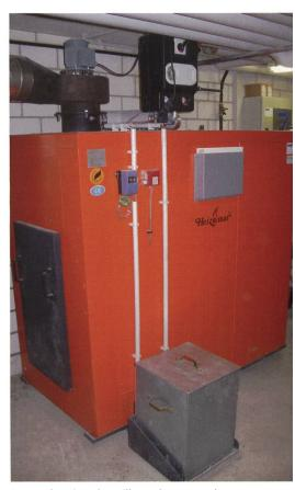
La combustion de paille et de roseau de Chine demande une chaudière résistante à la corrosion et l'adaptation du réglage de la chaufferie.
