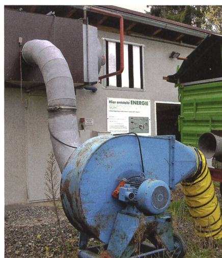
Installation de séchage de céréales à partir de la chaleur du CCF.
