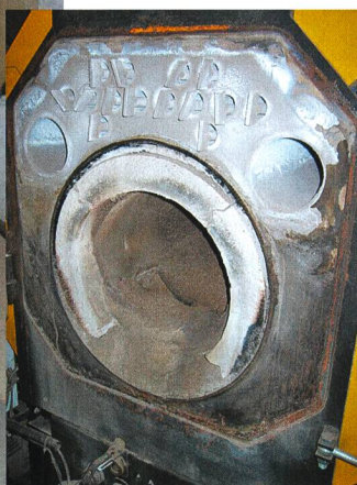
La chaudière est nettoyée en moyenne quatre fois par période de chauffe. Grâce à un aspirateur industriel performant, équipé d'un dispositif de séparation de la suie, cette opération se fait sans dégagement excessif de poussière.
