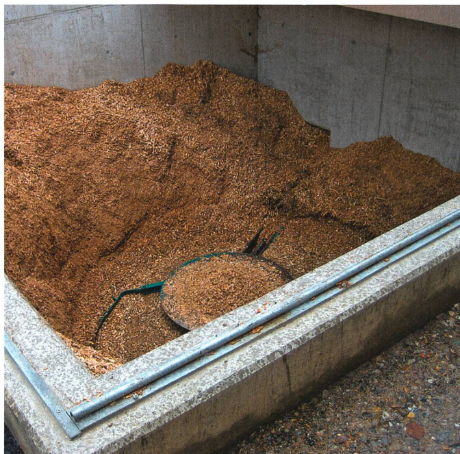
Un conteneur à plaquettes d'une capacité de 2 semaines et un système de reprise simple constituent des mesures essentielles contre des coûts excessifs. Pour le stockage de longue durée et le séchage ultérieur, des halles d'entreposage ouvertes sont nettement plus appropriées et meilleur marché.
