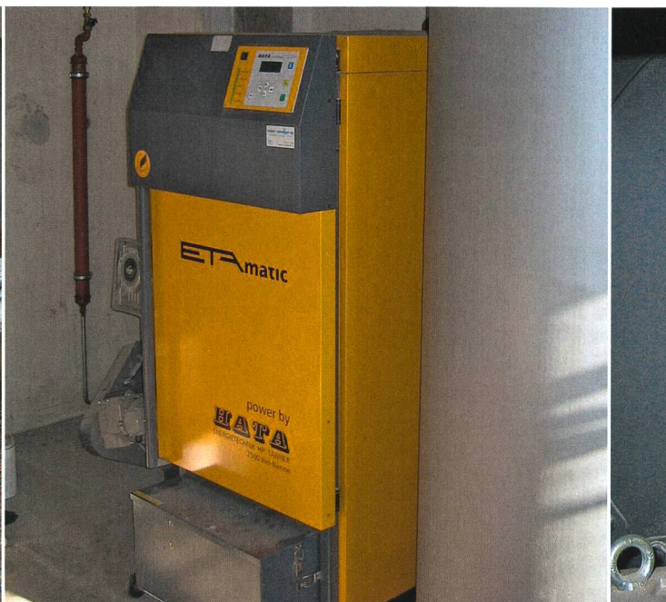
Installation de chauffage à plaquettes d'une exploitation agricole qui alimente également un réseau de chauffage reliant les habitations individuelles voisines.
