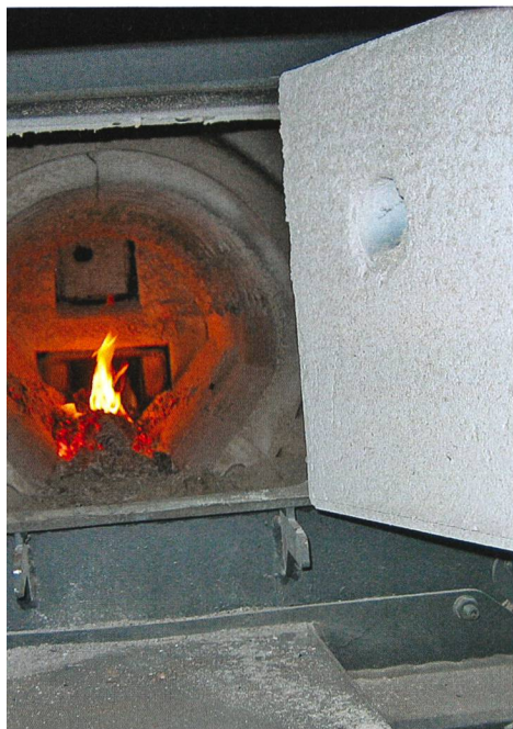
Installation de chauffage à plaquettes d'une exploitation agricole qui alimente également un réseau de chauffage reliant les habitations individuelles voisines.
