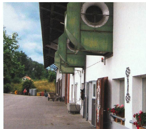
Air aspiré plus sec grâce à l'exposition sud et au montage sous toiture.
