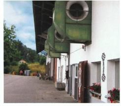
Air aspiré plus sec grâce à l'exposition sud et au montage sous toiture.
