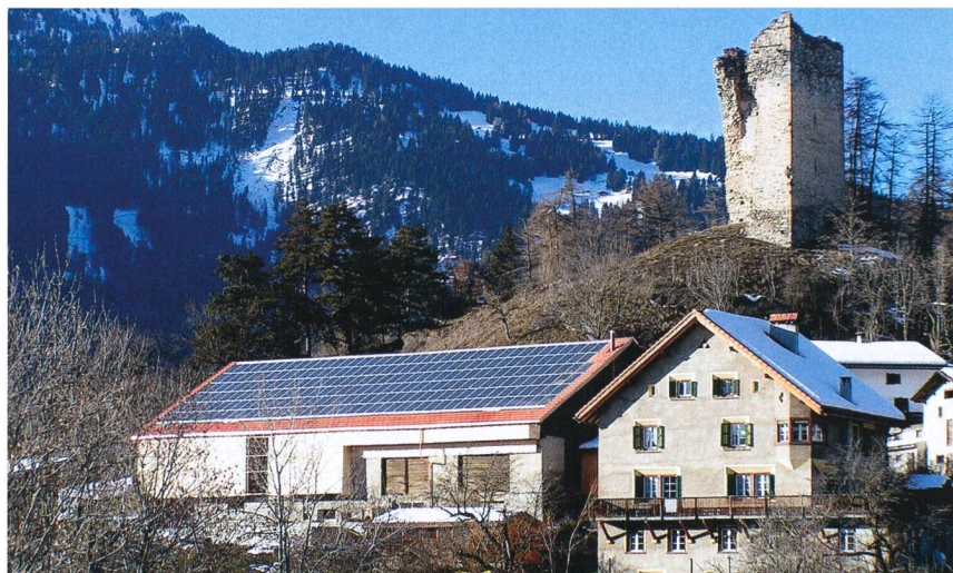
Fig. 1: Installation intégrée dans la toiture.
