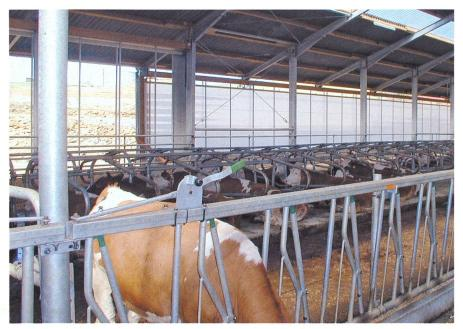
Les filets coupe-vent, qui peuvent s'enrouler au besoin, constituent une solution idéale afin de maintenir une circulation d'air minimale dans l'étable.
