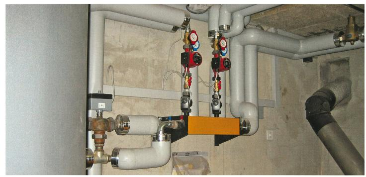
De gauche à droite: Accumulateur de chaleur central, vanne de remplissage (à 3 voies), 2 pompes de brassage et vanne de mixage pour le circuit de chauffage et le remplissage du boiler, raccordements vers la chaudière à bûches. (Photos: Ruedi Gnädinger)
