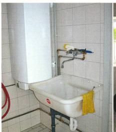
Station de lavage et d'eau chaude pour étable à veaux avec boiler propre (pas de déperdition de chaleur.
