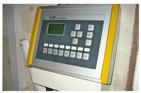
Les boîtiers de commande des chaudières et des installations de chauffage modernes comprennent directement un module de gestion du boiler et de l'installation solaire.
