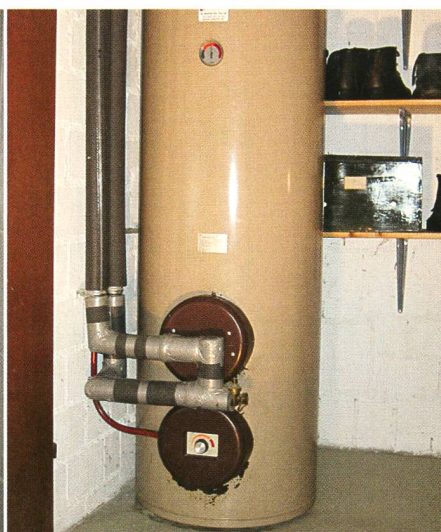
Boiler vertical simple avec système de chauffe électrique et raccordement au circuit de chauffage.
