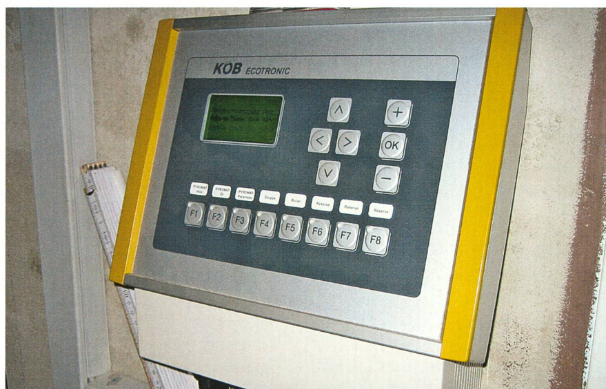
Les boîtiers de commande des chaudières et des installations de chauffage modernes comprennent directement un module de gestion du boiler et de l'installation solaire.
