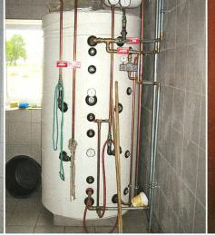
Accumulateur à eau chaude central d'une installation de récupération de chaleur de refroidissement du lait.
