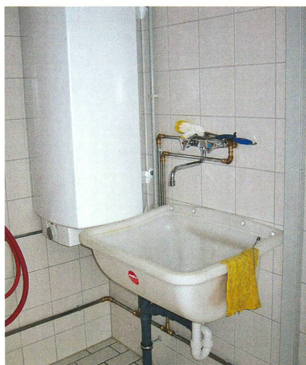
Station de lavage et d'eau chaude pour étable à vœux avec boiler propre (pas de déperdition de chaleur).
