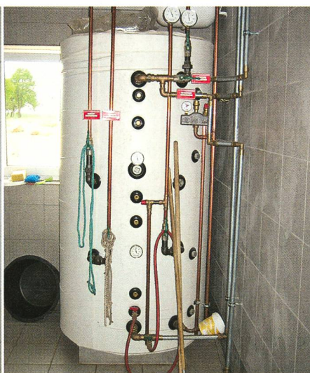
Accumulateur à eau chaude central d'une installation de récupération de chaleur de refroidissement du lait.
