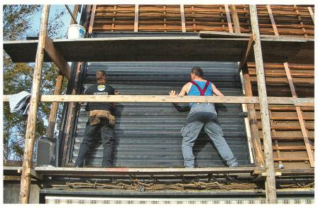
Montage de panneaux solaires sur une paroi verticale. La couverture doit encore être apposée. Des travaux personnels en collaboration avec l'entreprise sont tout à fait possibles dans ce cas.
