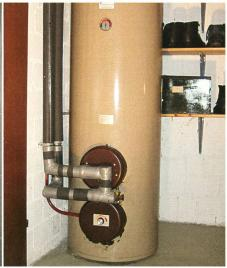
Boiler vertical simple avec système de chauffe électrique et raccordement au circuit de chauffage.
