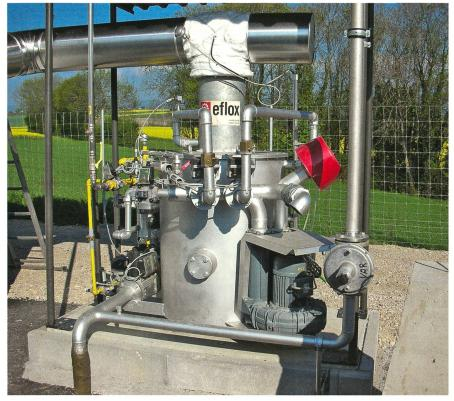
La station d'épuration du gaz gérée par COSVEGAS.
