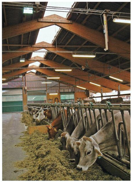
Eclairage d'étable constitué d'une combinaison entre lampes FL et lampes à vapeur d'halogénures métalliques pour l'aire d'affouragement et la fourragère. (Photo: Ludo van Caenegem, Agroscope ART).
