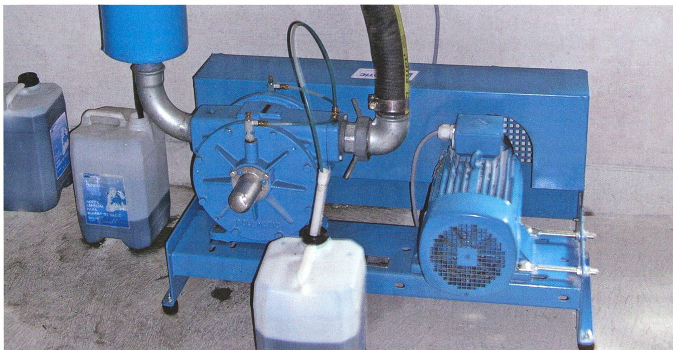
Le montage de la pompe à vide sur des supports élastiques adaptés à son poids et des raccords souples de l'échappement et de la conduite principale évitent la propagation des vibrations. (Rapport FAT 625)
