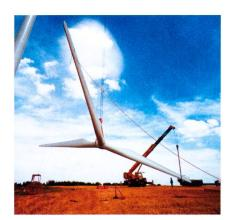
Fig. 3: Montage de l'installation avec deux grues. Un site adapté est notamment un site auquel on peut accéder avec de lourds engins de transport, très longs.
