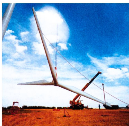
Fig. 3: Montage de l'installation avec deux grues. Un site adapté est notamment un site auquel on peut accéder avec de lourds engins de transport, très longs. (Photo: Bundesverband Windenergie, Allemagne)
