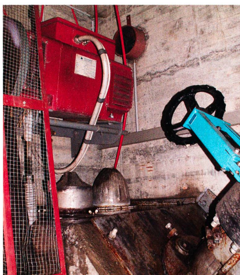
Un générateur Bartholdi fournit l'électricité du Bundalp.
