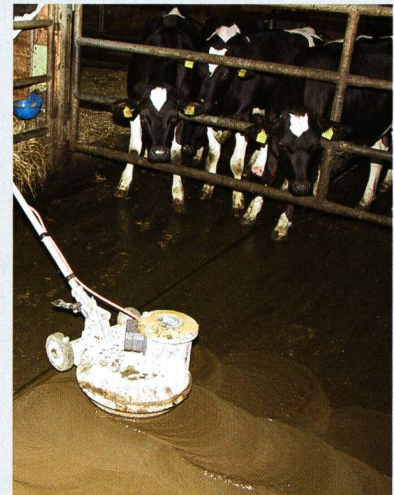
Fig. 3: Les revêtements d'asphalte coulé devenus trop abrasifs peuvent être assainis à plusieurs reprises par un meulage ciblé.
