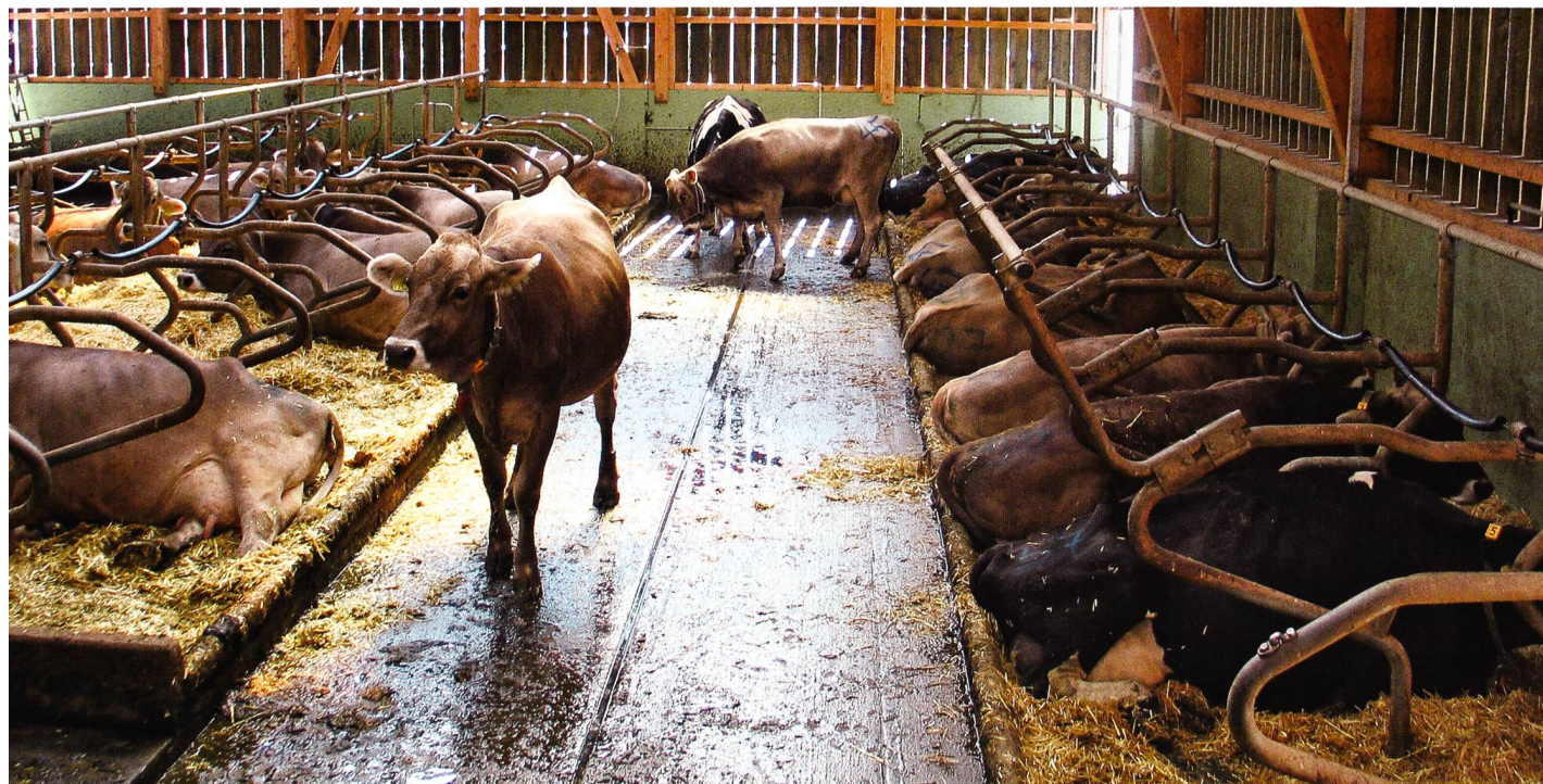
Fig. 1: L'exécution de revêtements d'aires de circulation dans les étables pour bovins doit répondre à des exigences telles qu'une bonne adhérence et une stabilité chimique.
