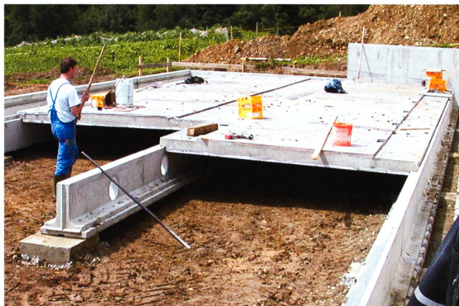
La chaleur terrestre peut être utilisée par le biais de serpentins ou d'une cavité aménagée sous la porcherie. En hiver, l'air est réchauffé, ce qui économise de l'énergie de chauffage. En été, la porcherie est refroidie (photos: ART, Krieger, mo).
