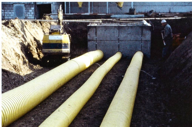
La chaleur terrestre peut être utilisée par le biais de serpentins ou d'une cavité aménagée sous la porcherie. En hiver, l'air est réchauffé, ce qui économise de l'énergie de chauffage. En été, la porcherie est refroidie (photos: ART, Krieger, mo).
