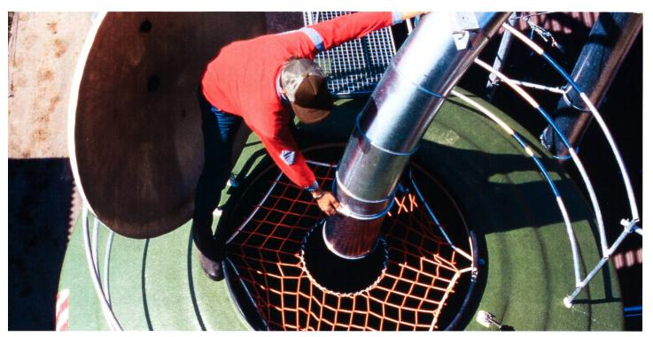
Un centrage précis du coude de remplissage est déterminant pour la mise en place de couches régulières. A noter la sécurité antichute: exemplaire autant qu'indispensable. (Photo: SPAA)
