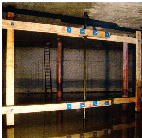
Brasseur à pales de diamètre de 6,5 m sans paroi armée. La firme Mai AG à Huttwil s'est spécialisée dans la construction de ce type de brasseurs. Chaque brasseur est conçu sur place selon les conditions locales spécifiques (photo Mai SA, Huttwil).
