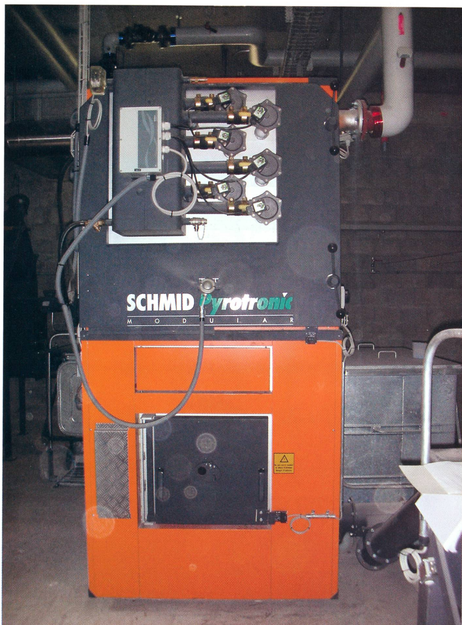
Pour faire face à la demande croissante, la chaudière de 360 kW a été complétée par une chaudière de 720 kW.
