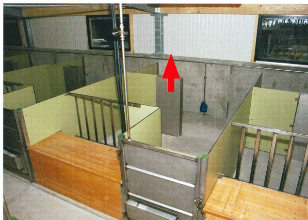
Fig. 3: Vue intérieure de la porcherie Krieger. L'air frais pénètre à l'intérieur de la porcherie par une cheminée située entre l'aire de repos et l'aire de déjection (photo entreprise Krieger).
