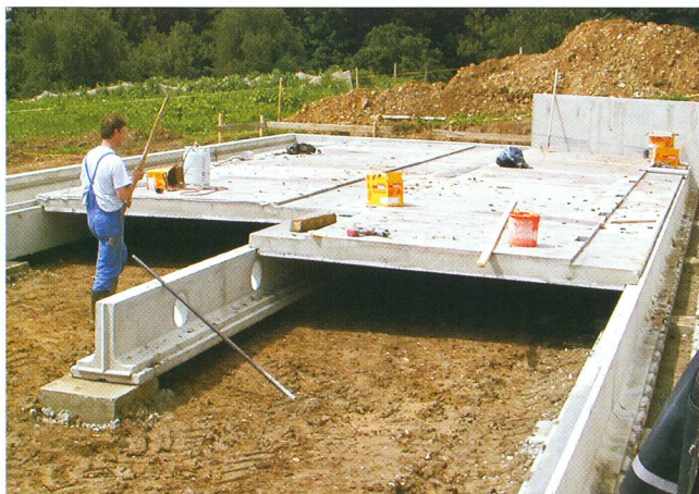
Fig. 2: Sous les dalles en béton préfabriqué se situe un espace libre qui peut être utilisé pour le conditionnement de l'air d'amenée (photo entreprise Krieger).
