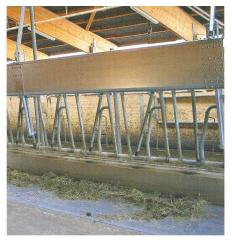
Fig. 3: Pour faciliter le nettoyage de l'aire d'affourragement, le bord de crèche est relevé
