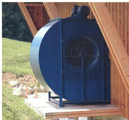
Fig. 3: Pour le séchage en grange, il faut disposer de ventilateurs testés avec un bon rendement et des valeurs de bruit réduites (photo: Schmidlin, ART Tänikon).
