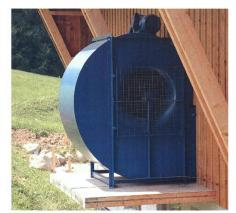
Fig. 3: Pour le séchage en grange, il faut disposer de ventilateurs testés avec un bon rendement et des valeurs de bruit réduites (photo: Schmidlin, ART Tänikon).
