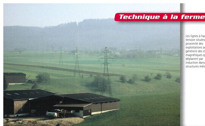
Les lignes à haute tension situées à proximité des exploitations agricoles génèrent des champs magnétiques qui se déplacent par induction dans les structures métalliques.
