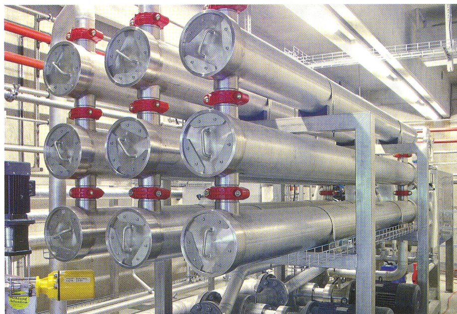
L'osmose inverse a comme effet d'une part de l'eau dite propre et d'autre part un liquide riche en N et K. (Photo: Hersener)
