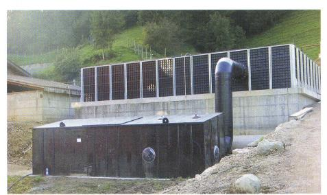
Biofiltre: L'air vicié doit être traité quant aux odeurs avant d'être libéré dans l'atmosphère.
