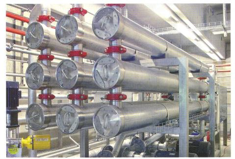
L'osmose inverse a comme effet d'une part de l'eau dite propre et d'autre part un liquide riche en N et K. (Photo: Hersener)
