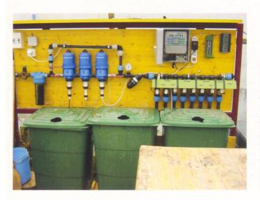
Doseurs d'engrais à gauche en bleu, électrovannes à droite avec les étiquettes vertes pour arroser chaque secteur séparément, filtres et, en haut, station de programmation et instruments d'observation météorologiques: voici comment se présente la tête d'une installation d'irrigation localisée simple.
