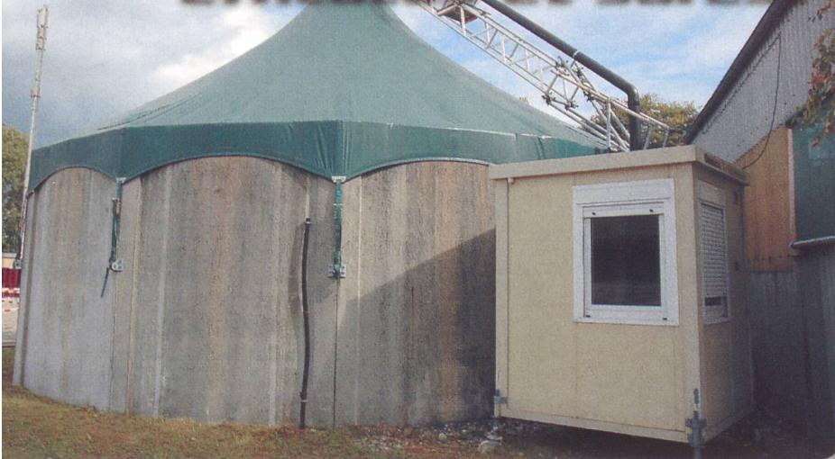
Réservoir à lisier couvert de 400 m<sup>3</sup> à la FAT. Pour les besoins de la recherche, le tuyau d'aspiration, qui se trouve au faîte du toit bâché, sert à contrôler le prélèvement du mélange gaz-air pour en analyser sa composition. Les coûts pour une couverture fabriquée en série s'élèvent ici à CHF 25000 ou à CHF 63.– par m<sup>3</sup> de volume d'entreposage du lisier. Pour une fosse à lisier de dimension égale (400 m<sup>3</sup>), il faut compter 50% de dépenses en plus.
