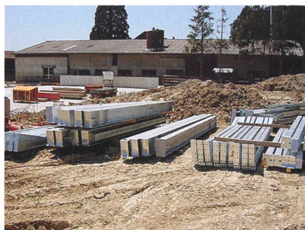
...une partie des éléments de la structure métallique juste avant le montage...
